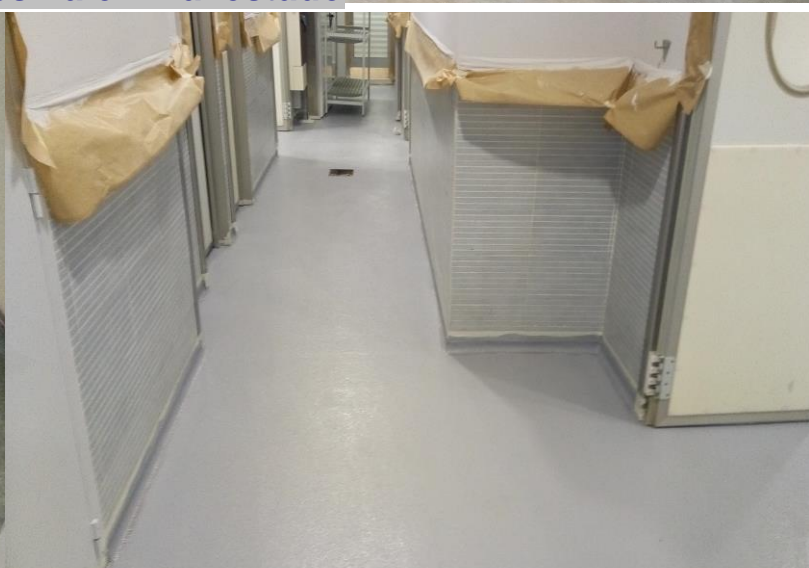
Resultado final con acabado antideslizante
